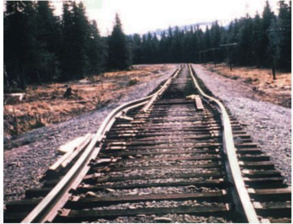
الشكل 1-20 لقد تسببت درجات الحرارة العالية أيام الصيف الحارة في تقوس مسارات سكة الحديد.
